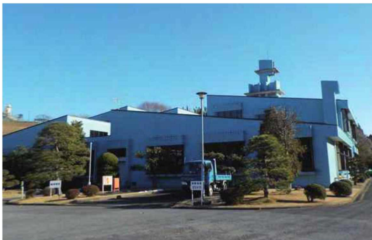
写真：成田浄化センター
