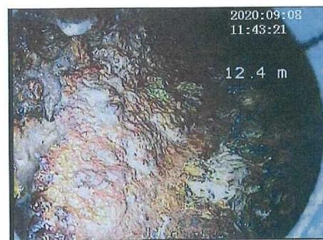
B棟 横引き管 管底部腐食（隆起）の状況
