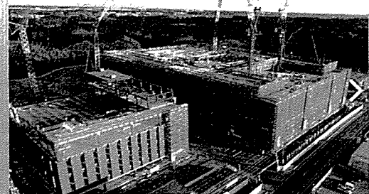
◀ 施工中の国際医療福祉大学附属病院
