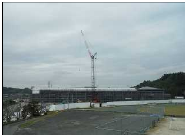
新校舎の全景、躯体工事は10月に完了
