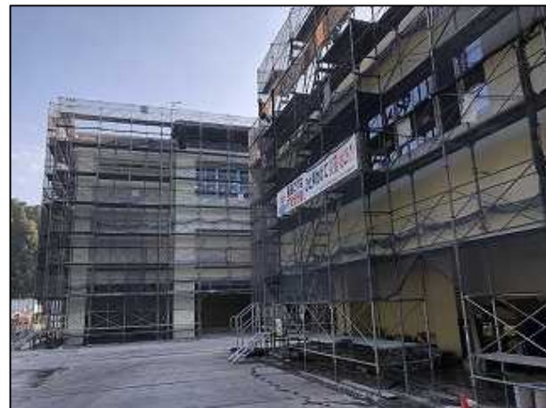
大アリーナ・小アリーナの外壁塗装工事の状況
