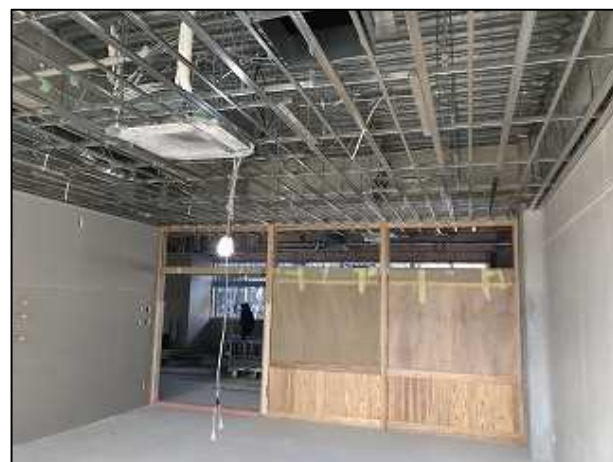
南棟校舎1階 特別支援教室の内装工事の状況
