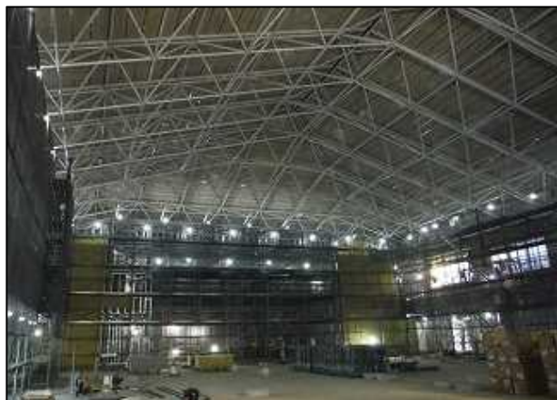
大アリーナの内部、正面足場の奥がステージ
