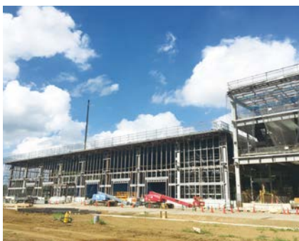
建設工事中新市場
