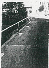
市道の安全手すり設置
