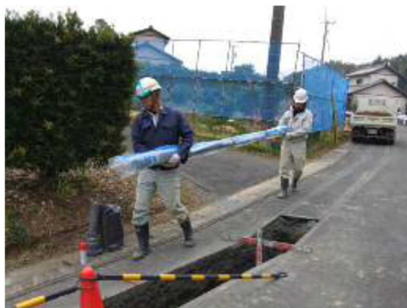
図 4.2.8 NS 形 E 種管*の施工風景
