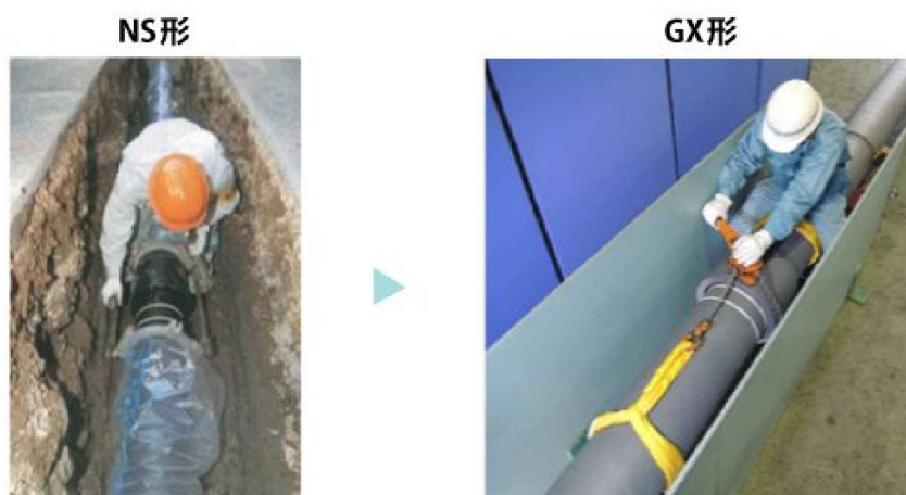
図 4.2.5 ダクティル鑄鉄管 GX 形*施工風景
