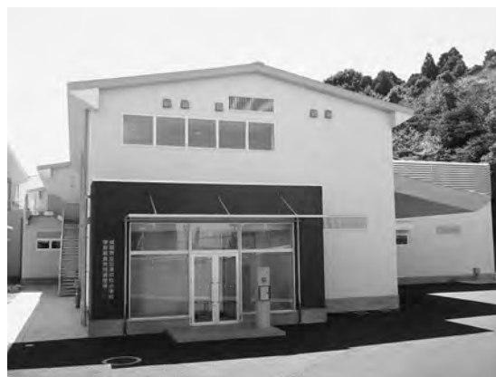
公津の杜小学校学校給食共同調理場
