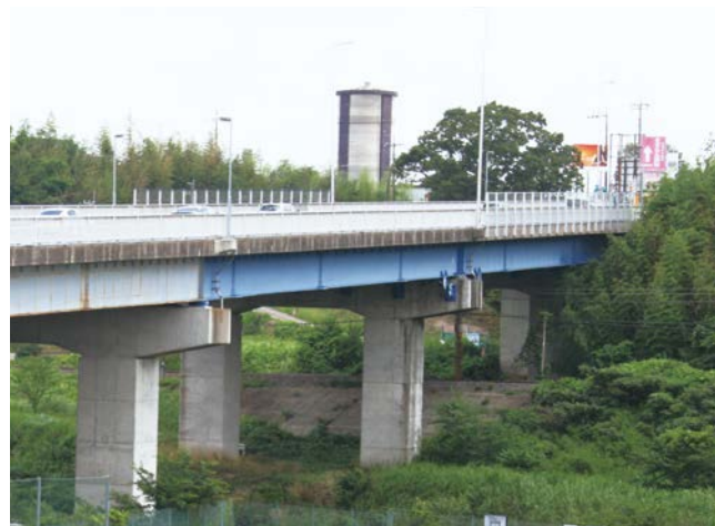
工期が延長された郷部大橋
