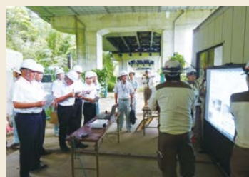
郷部大橋補修工事の視察
