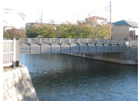
▲桁から高欄まで木材で統一され、石積擁壁と調和した落ち着いた景観をつくり出している。【②】
