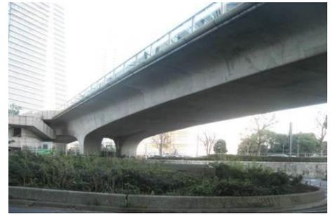
▲ 桁と橋脚を柔らかい曲線の仕上げとし、圧迫感の軽減が図られている。【①】
