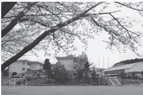
「新しくなった校舎」 室内もとてもきれいで快適です。
