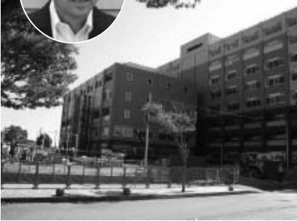
▲建設中の国際医療福祉大学看護学部
