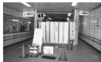
▲工事が進められている京成成田駅東口
