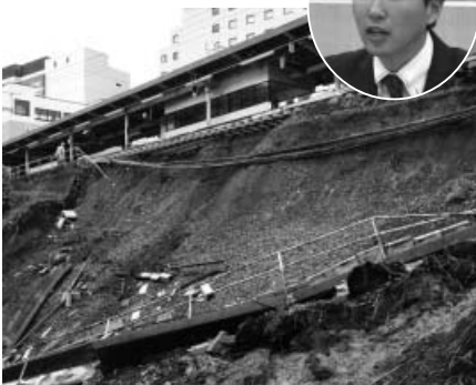
▲台風26号に伴い発生した崖崩れ
