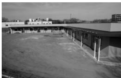
▲建設中の赤坂保育園
