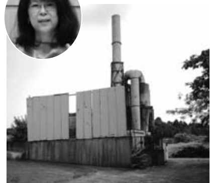
▲不法投棄跡地の残存焼却炉
