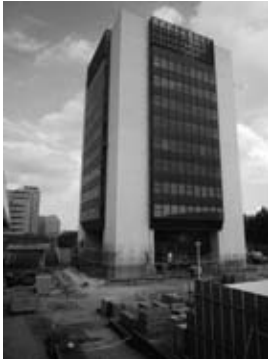
▲解体が進む赤坂センタービル
