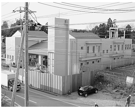
▲建設中の赤坂消防署公津分署
