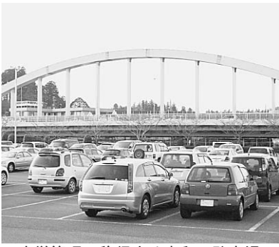
▲直営管理に移行する東和田駐車場
