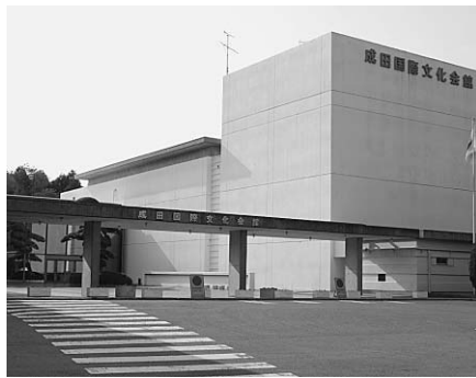
▲大規模改修工事が予定されている国際文化会館
