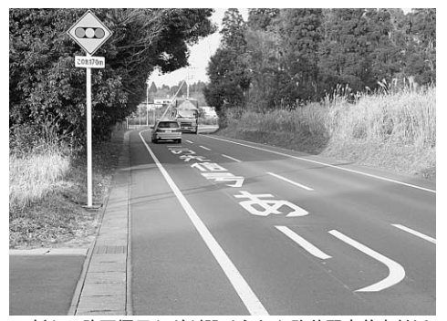
▲新たに路面標示などが設けられた駒井野交差点付近
