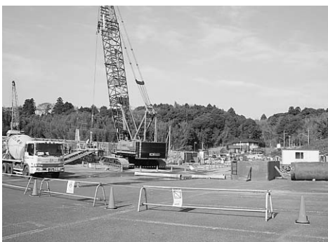
▲工事が進む成田ニュータウン北駅予定地
