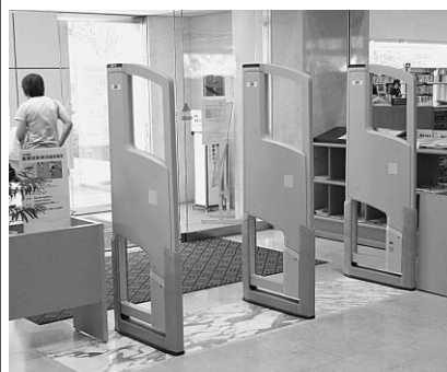
▲図書館に設置された貸出手続確認装置
