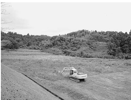
▲拡張整備が行われるいずみ聖地公園隣接地
