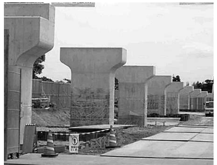
▲鉄道橋脚工事が進む大谷津運動公園
