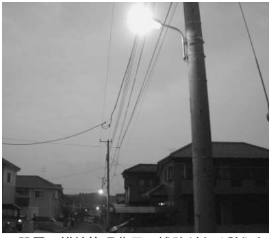
▲設置・維持管理費用の補助がある防犯灯
