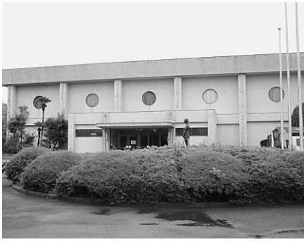
▲耐震補強などが行われる下総中学校体育館
