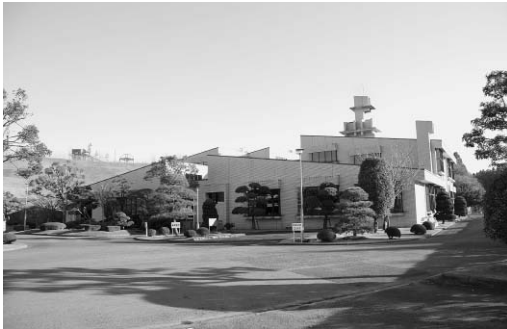
▲吉倉にある“成田浄化センター”
