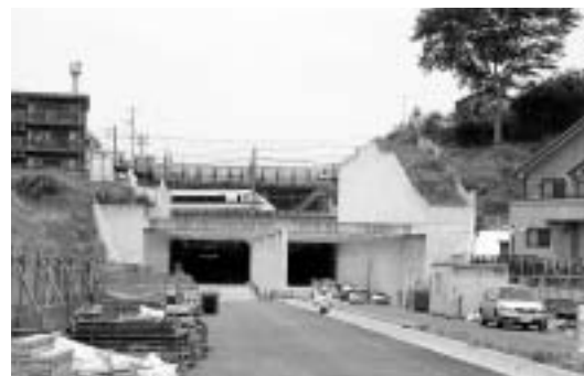
▲国道51号から見た工事中の“こ道橋”
