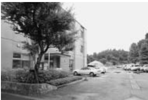
▲リサイクルプラザ隣の建設予定地
