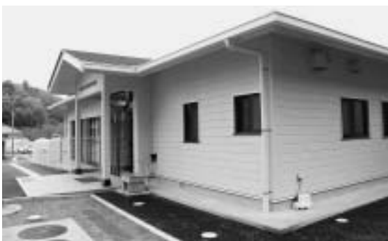
▲完成した大山共同利用施設
