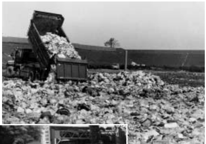
平成元年4月、十余三につくられたごみの最終処分場「成田クリーンパーク」
