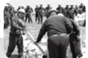
堤防の決壊を防ぐ水防工法を実践
