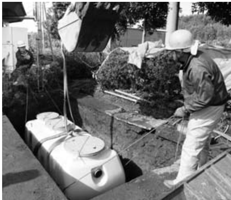
浄化槽の設置工事の様子
