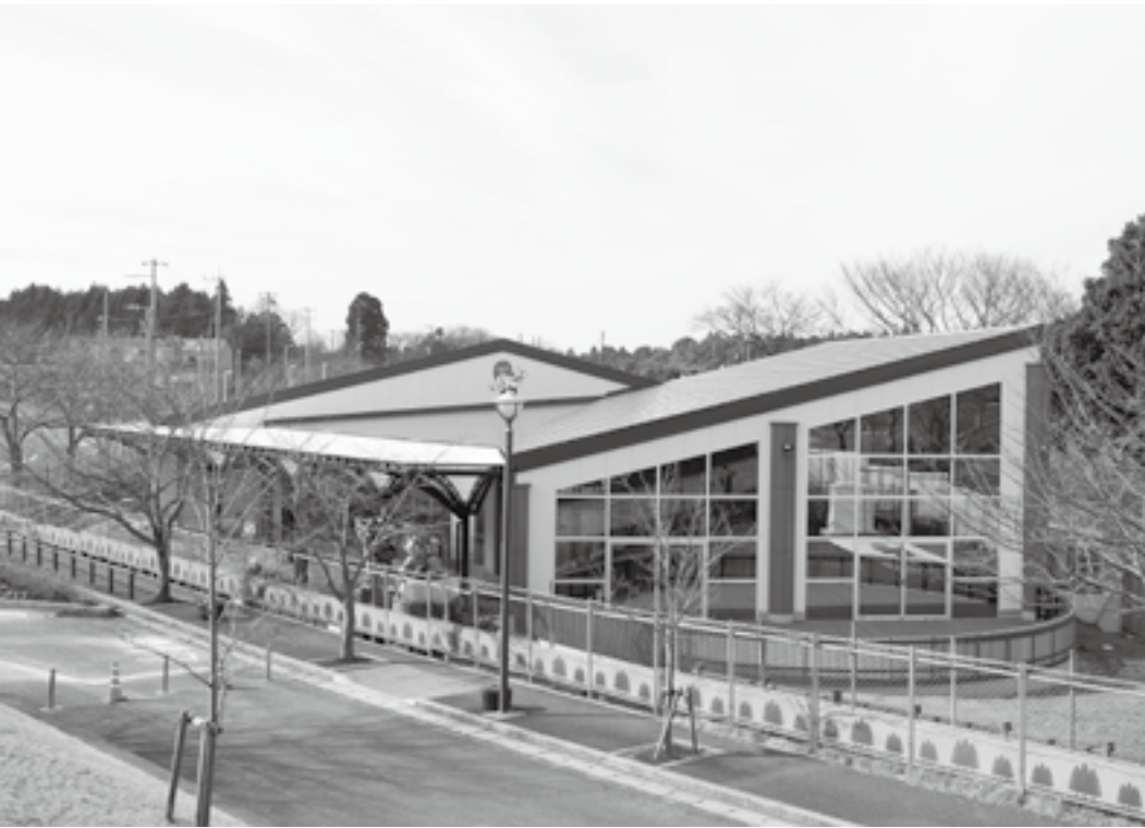
完成に向けて工事が進む「空の駅 さくら館」
