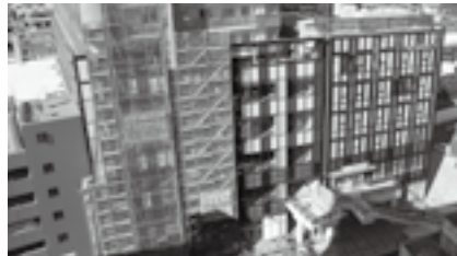
工事が進む「スカイタウン成田」
