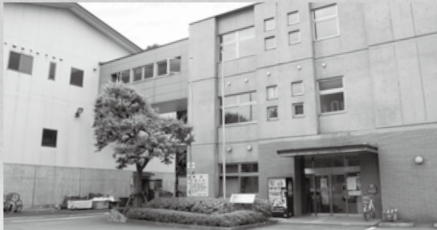
平成10年4月から稼働しているリサイクルプラザ
