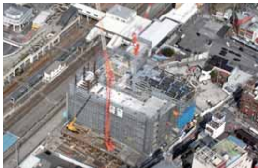
着々と建設工事が進むJR成田駅東口の再開発ビル
