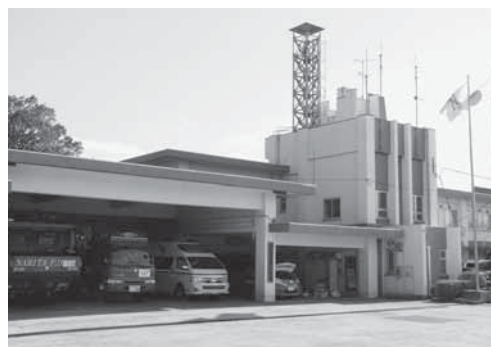
昭和46年に建設され、老朽化が進む三里塚消防署
