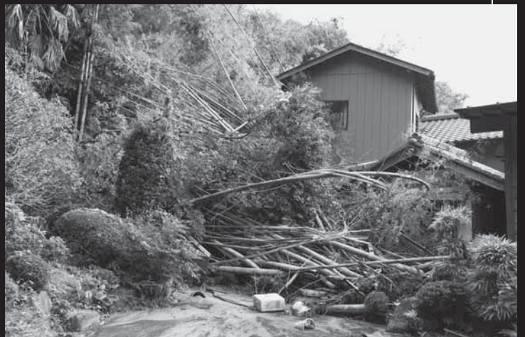
崖崩れで家屋が損壊(伊能地先)
