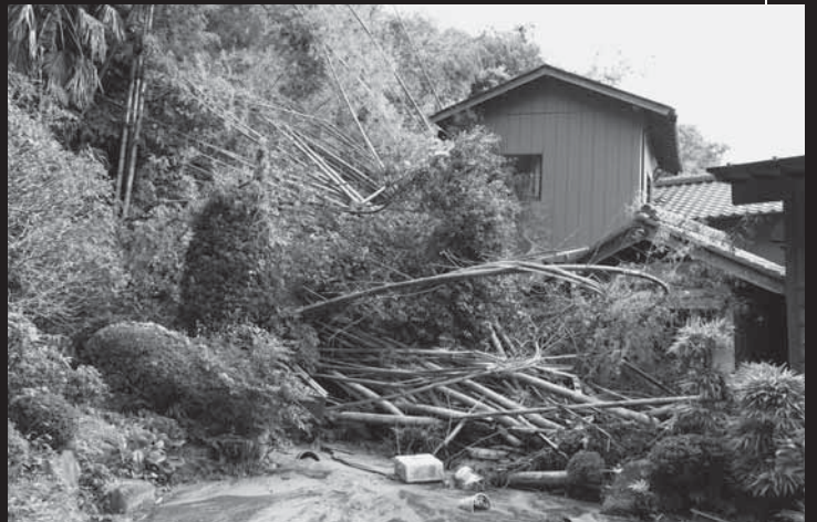
崖崩れで家屋が損壊(伊能地先)
