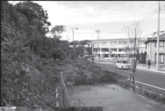
歩道をふさぐ土砂 (成田湯川駅周辺)
