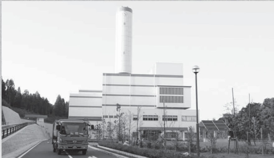
再資源化を推進する成田富里いずみ清掃工場
