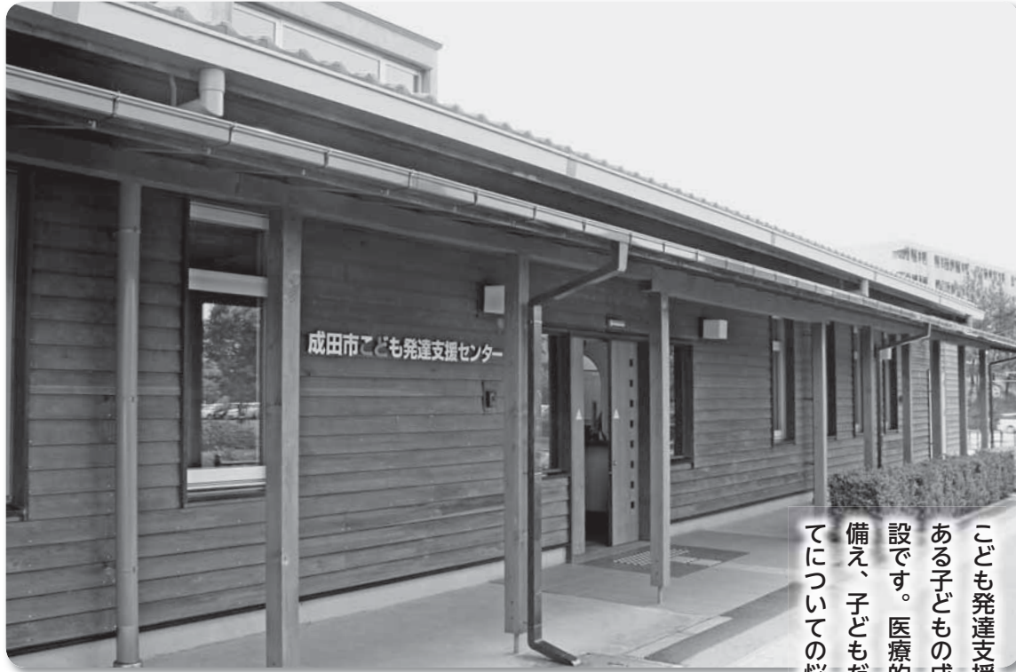
保健福祉館の敷地内に建つこども発達支援センター
