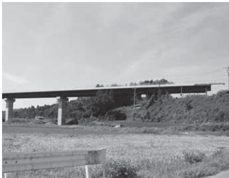
着々と工事が進む「大栄～稲敷」間(芝地先)
