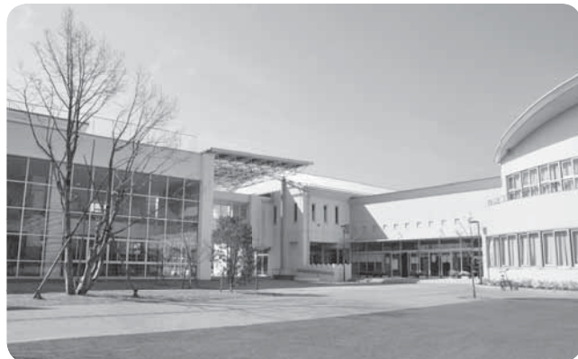
増築された校舎
