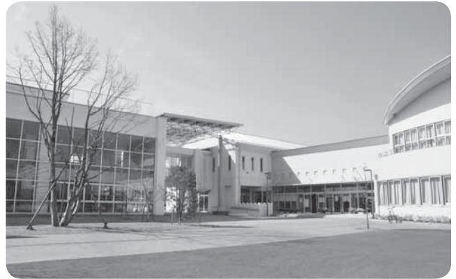
増築された校舎
