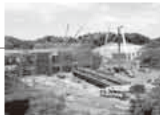
建設の進む成田湯川駅
