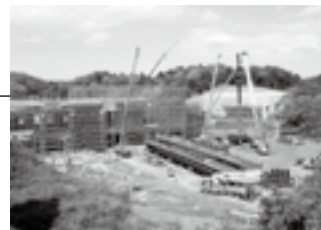
建設の進む成田湯川駅
