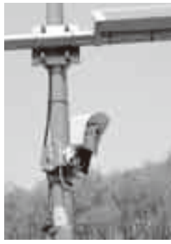
設置されているカメラ
