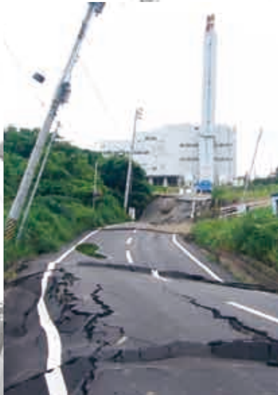
烈震に見舞われた新潟県柏崎市内。道路は陥没・隆起し、奥に見える建物（市クリーンセンター）の煙突部分には亀裂が（平成19年7月16日発生・新潟県中越沖地震：新潟県提供）
