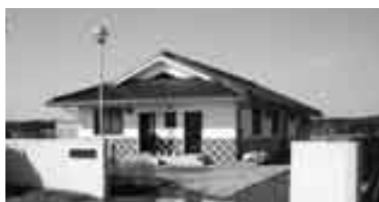
完成間近の汚水処理施設
