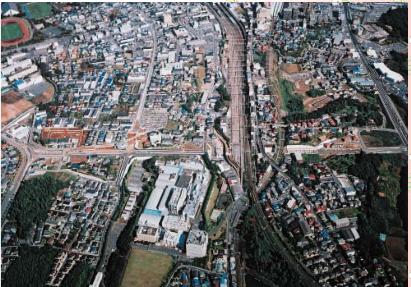
4月には国道51号とニュータウンを結ぶ都市計画道路・郷部線(写真中央)が開通
