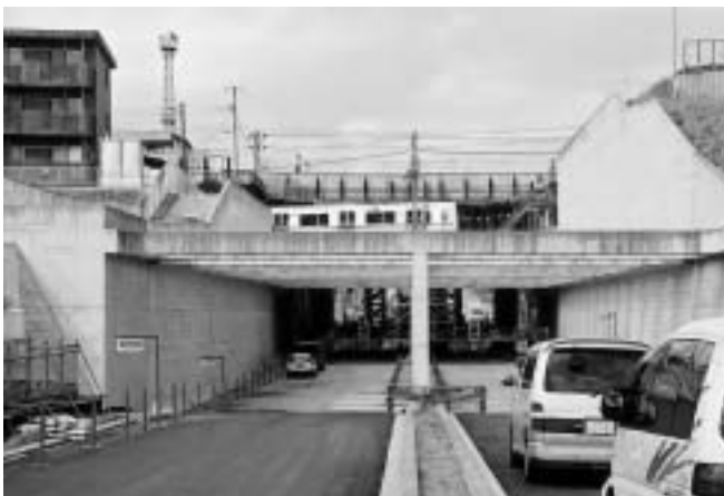
トンネルが貫通した郷部線
