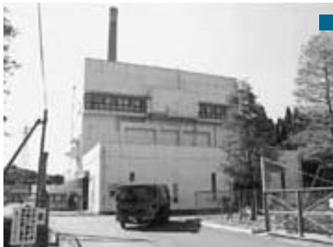
新施設の建設が急務 (いずみ清掃工場)
