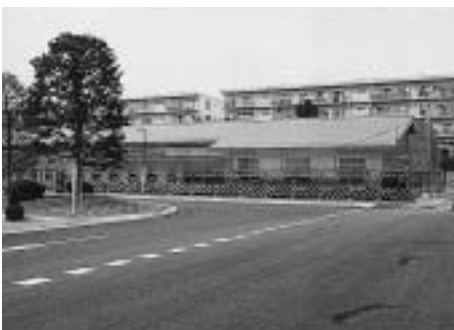
建設が進む夜間急病診療所(保健福祉館)
