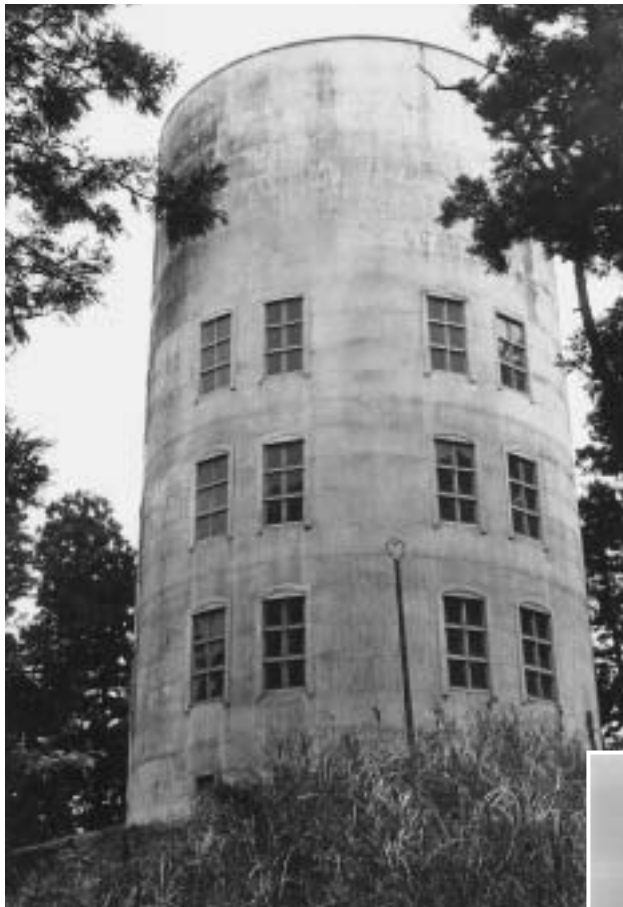
火災や停電時の断水防止、夏季の渇水時に安定給水が可能になった東町の高架配水塔（昭和34年8月）
