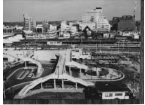
昭和61年3月に完成したJR成田駅西口広場。区画整理事業により、団護台・馬橋・新町地区が生まれ変わり、ニュータウンとJR成田駅が直結しました（平成6年10月1日：第796号「シリーズ成田市40年 掲載」）
