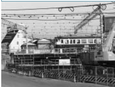
立体交差化工事が進む囲護台踏切
