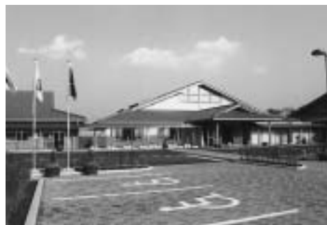
「夜間急病診療所」が建設される保健福祉館
