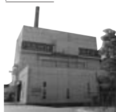
いずみ清掃工場排ガス高度処理施設整備事業
