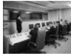
消防緊急通信指令施設更新事業
